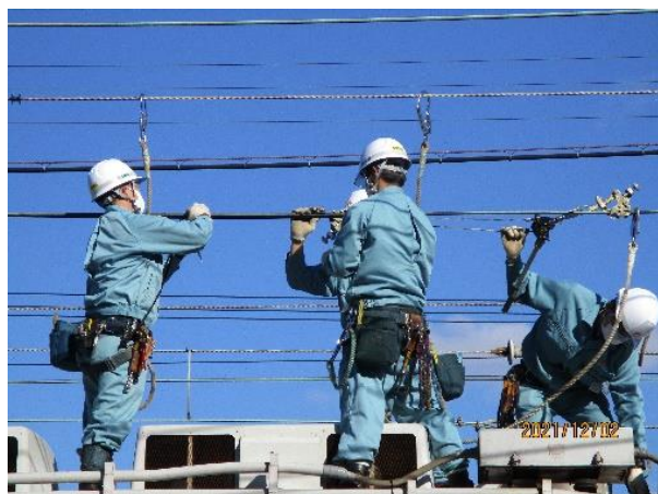
電力係員による復旧訓練
