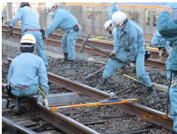
保線係員による復旧訓練
