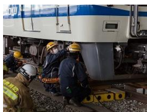
脱線車両の復旧
