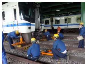
脱線車両の復旧
